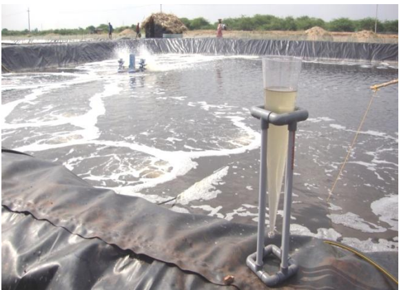
Aero-Tube diffusion aeration at Biofloc ponds
